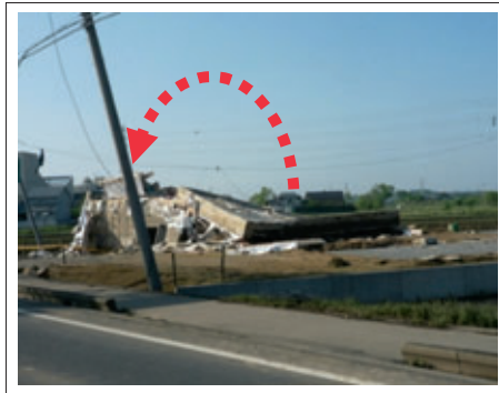
図4 上部構造の転倒（つくば市）
