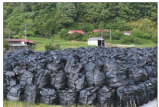
写真1 除染で発生した汚染土の一時保管状況
